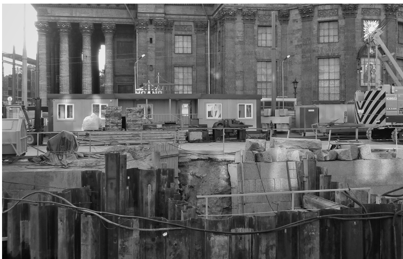
Набережная канала Грибоедова у Казанского собора. Повторный ремонт. 2013 г.
