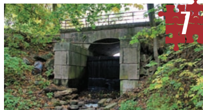
7 Мост Плотина The Dam-Bridge
