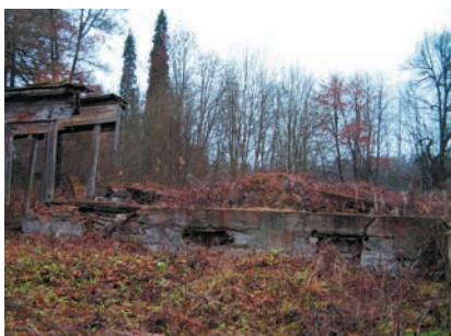
Руины главного корпуса усадьбы после пожара. 2005 г.
