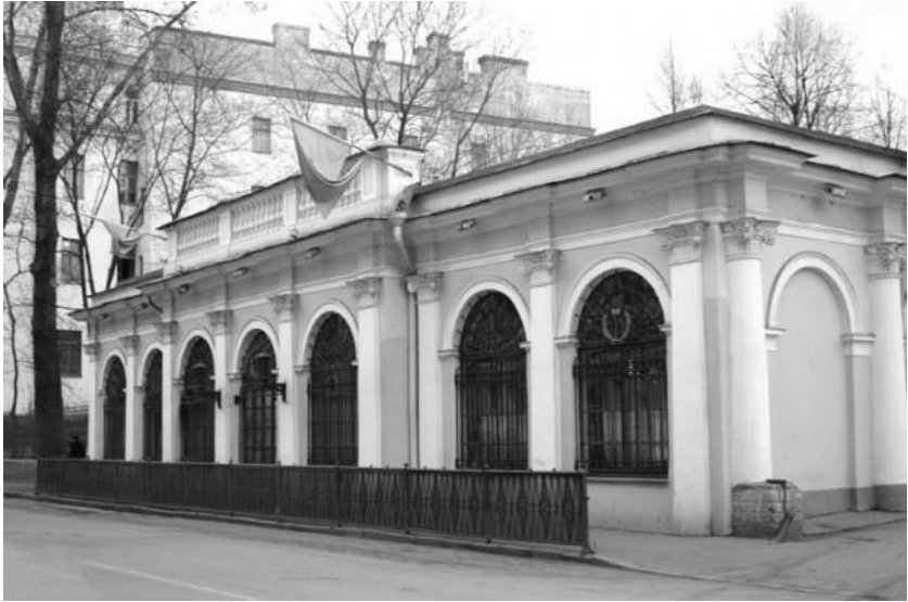
Рис. 3. Современный вид здания бывшего магазина школы садоводства на Офицерской ул., д. 21
