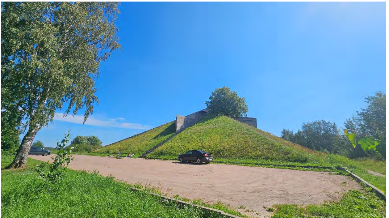
ФОТО 7. Вид в северо-восточном направлении на юго-западный угол памятника.
