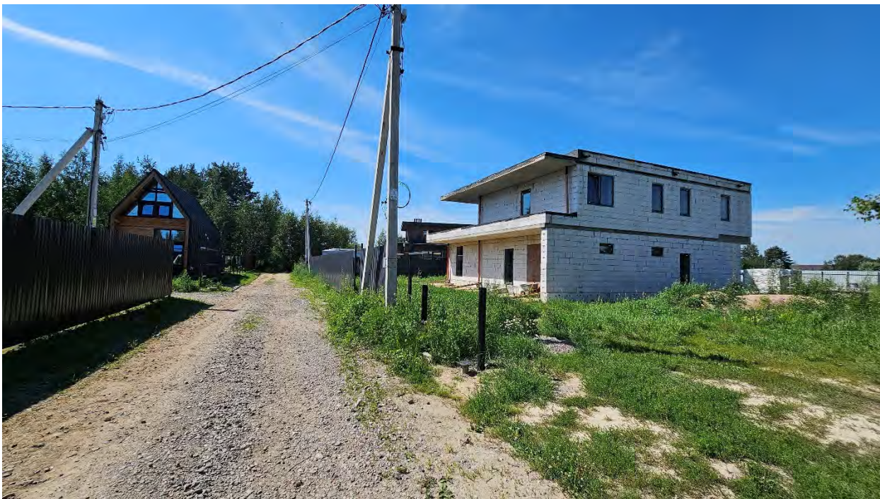
ФОТО 39. Вид в юго-западном направлении на застройку Полевой ул., ближайшей к «Памятнику «Безымянная высота». Расстояние до объекта исследования – 140 метров.
