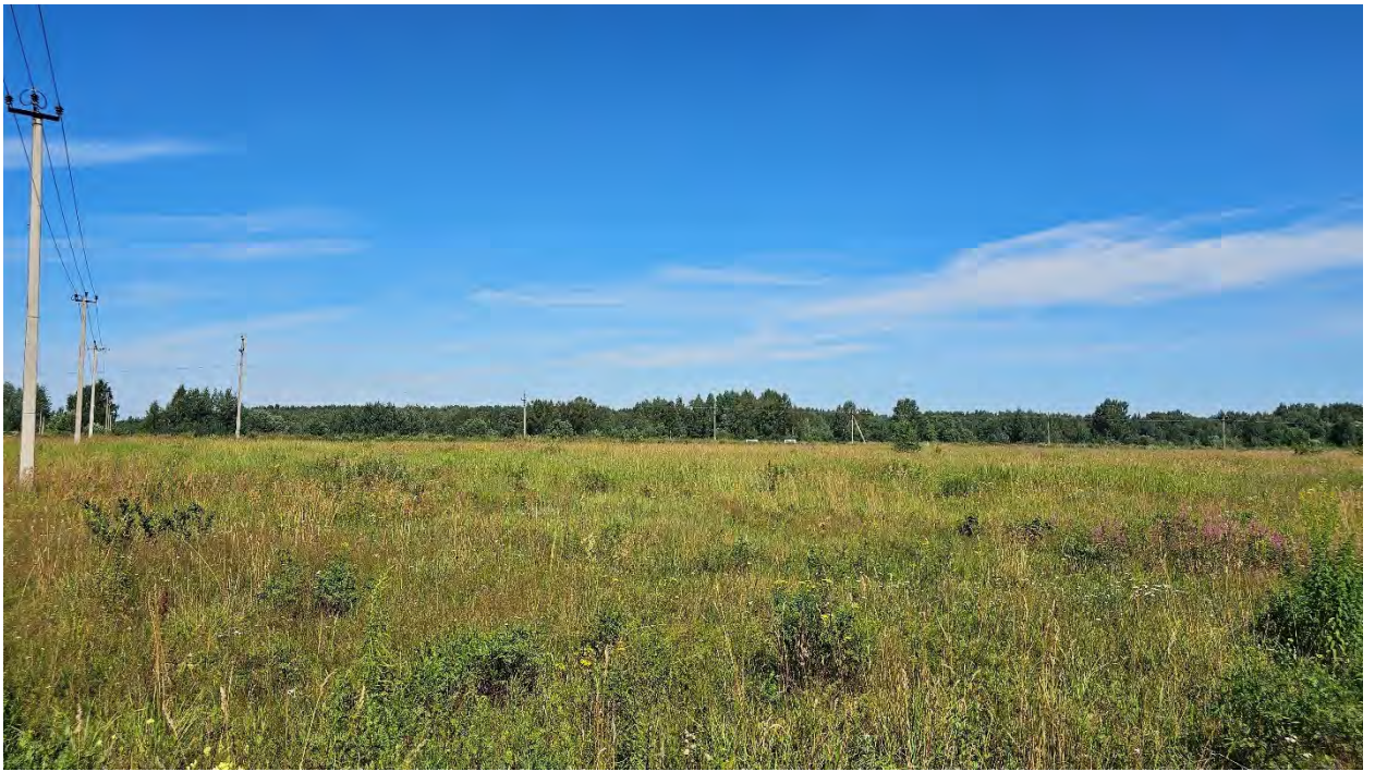
ФОТО 4. Вид в западном направлении на линию электропередач и незастроенные территории.
