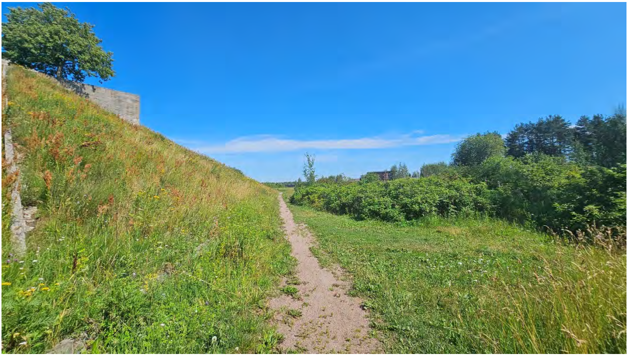
ФОТО 12. Вид в северном направлении вдоль набивной дорожки и восточной плоскости памятника. В правой части кадра заросли самосевной растительности в восточной части территории объекта культурного наследия.
